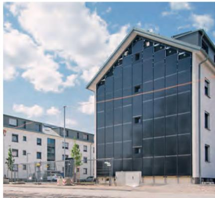
Zwischen den beiden SQUARE Gebäuden ist der Eisspeicher im Boden eingelassen (rechts). Die Südseiten beider Gebäude sind mit Solarkollektoren versehen (links).
